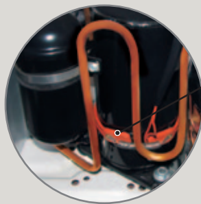
Нагреватель картера компрессора предотвращает холодный пуск.
